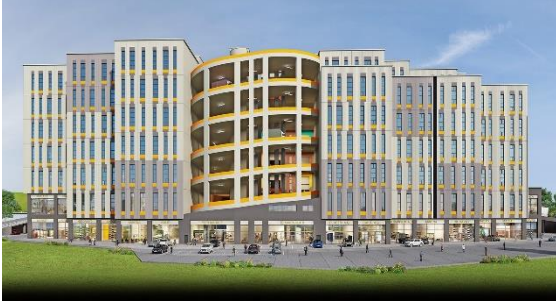
EŞBAH YAPI A.Ş İPEKYOLU PROJESİ
