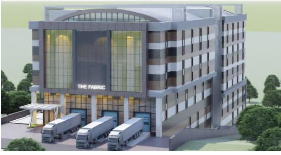
ÜÇTEPE YAPI EMLAK – ÖZYILMAZ MAKİNA PROJESİ
